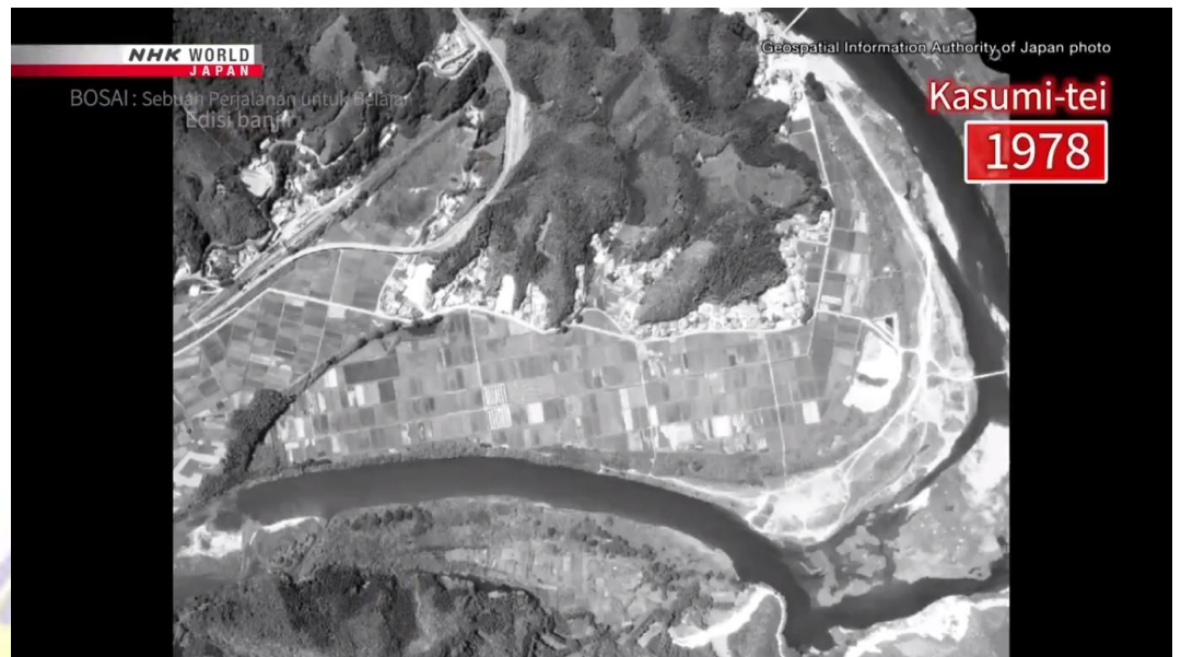
Gambar 4. 25 : Foto Bendungan Kasumi-Tei pada tahun 1978
