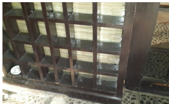
Gambar. 4.8. Morijio pada pintu masuk sisi kanan
